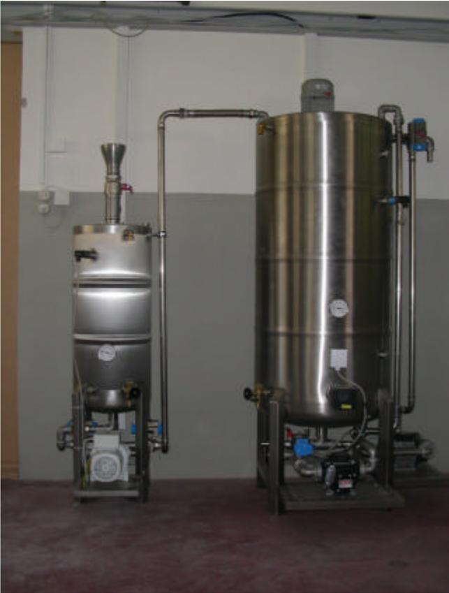
Nachdem genügend Öl aus dem Sammeltank in den in den Reaktor gepumpt wurde, und auf 55° C erwärmt wurde, wird anschliessend aus dem Vormischer das Methoxid in den Reaktor gepumpt. Das erwärmte Öl wird nun während gut 40 Minuten mit dem Methoxid durch ständiges und kräftiges Rühren vermischt.
